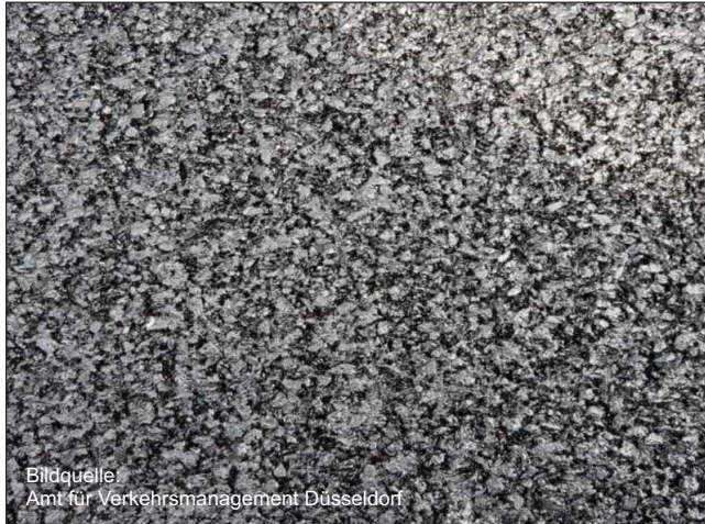
Beispiel Oberfläche lärmoptimierter Asphalt
